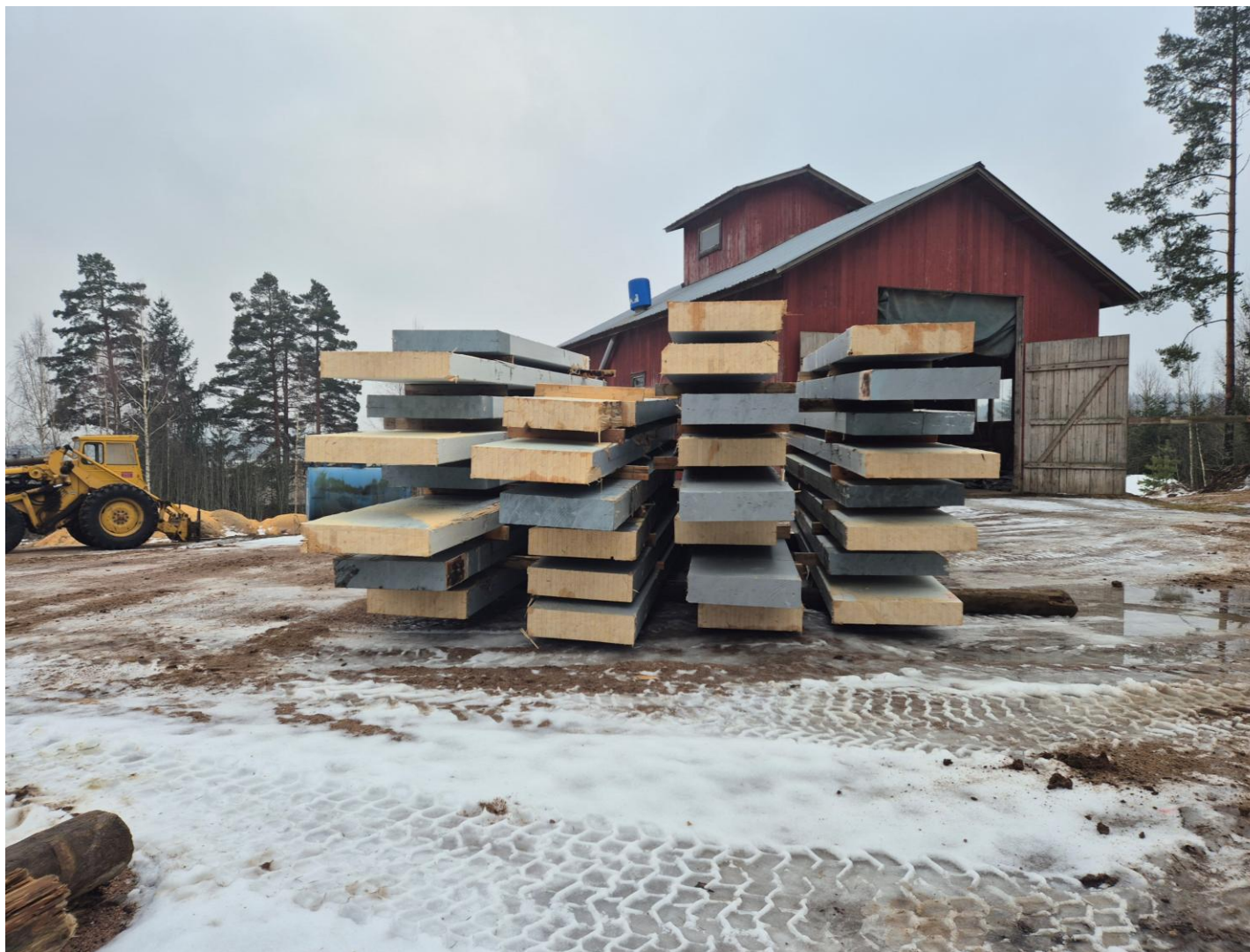
Ehjänä puretut liimapuurakenteet
