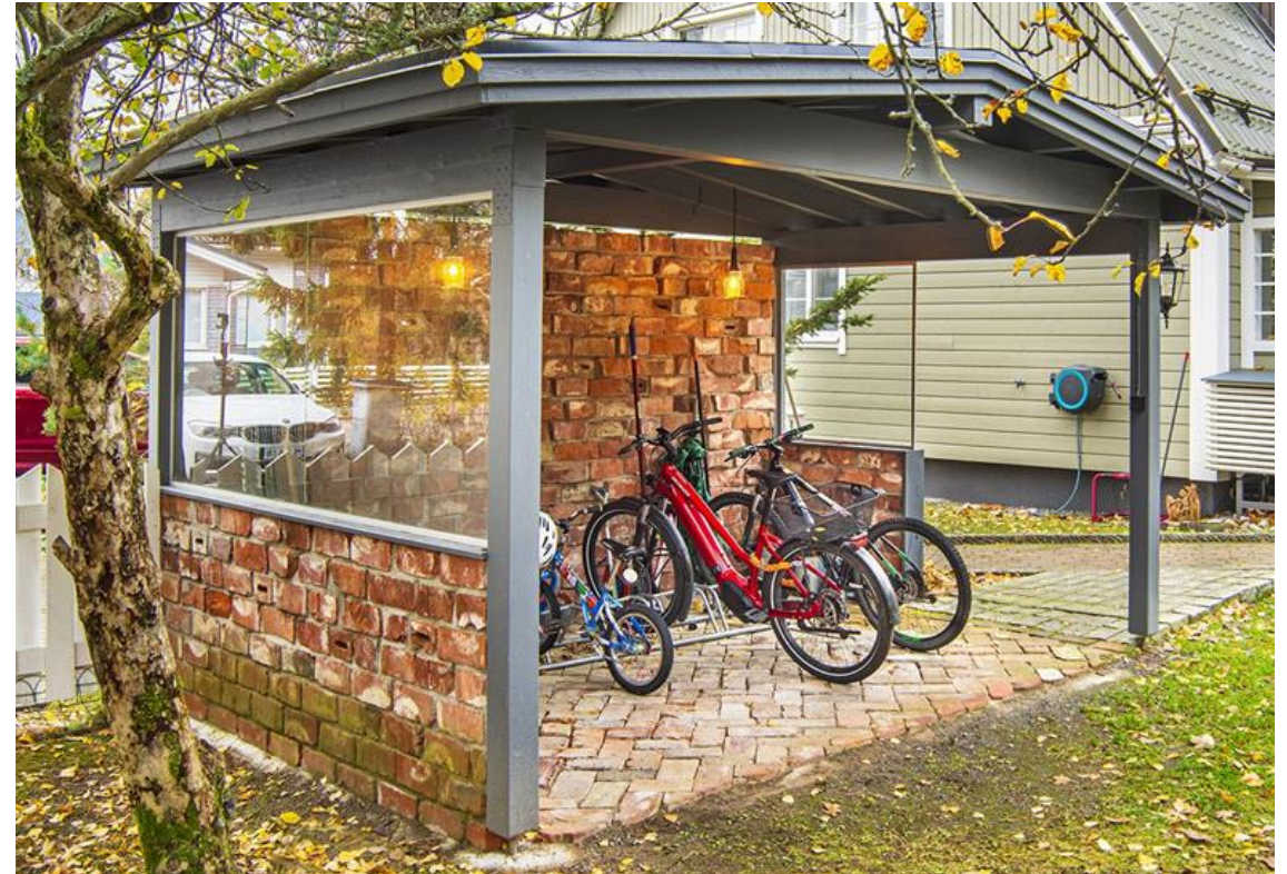
Yksityishenkilön rakentama pyöräkatos hyödyntäen purkutiiliä. Kuvalähde: https://www.rakentaja.fi/artikkelit/20783/pyorakatos_kierratys_tiilista.htm
