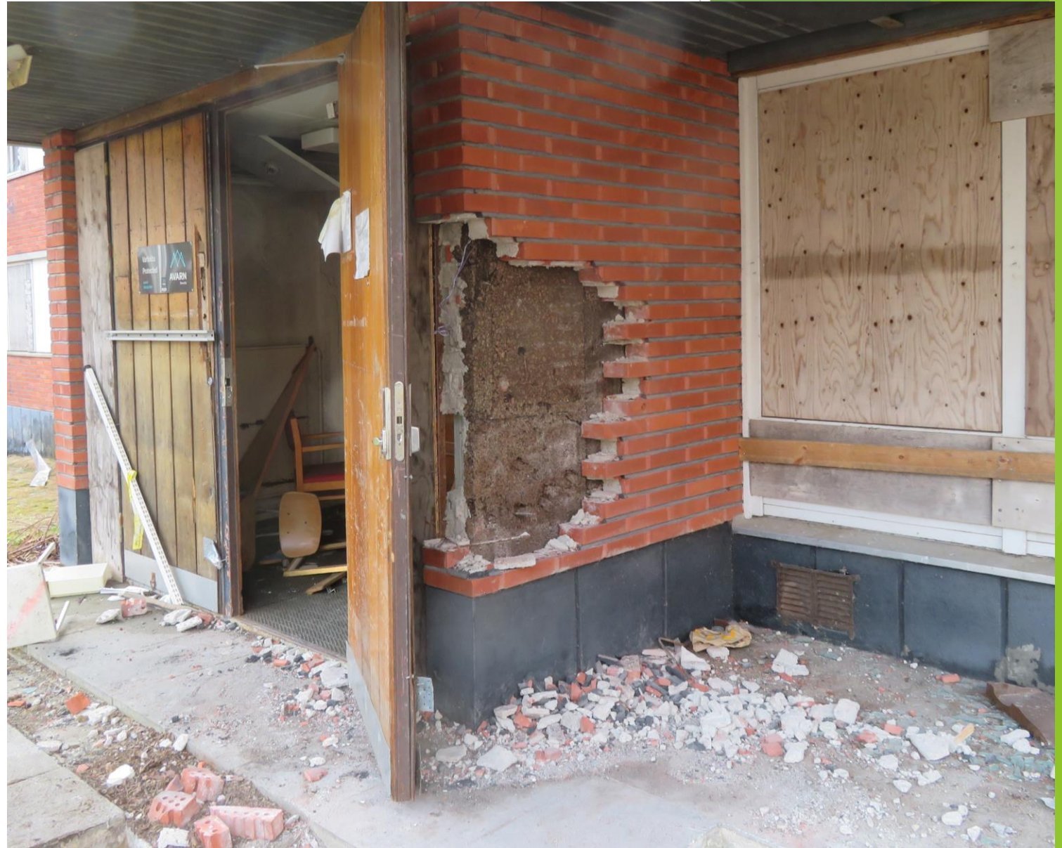
Tiilien irrotuskokeilu
